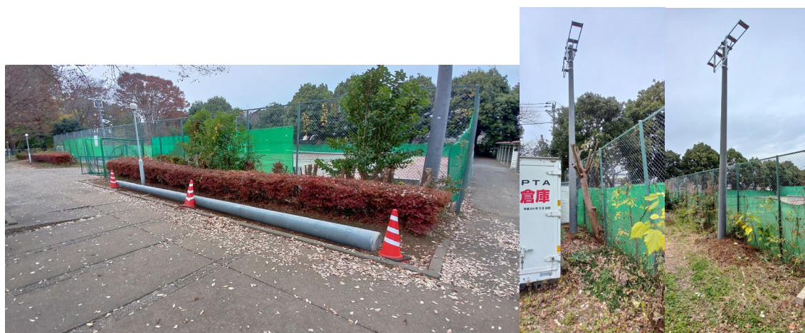
図表 62 建柱後のテニスコート様子（照明機材は未設置）
