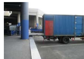
メルセデスベンツ・アリーナ(上海) トラックの段差に合わせた搬入口 出典：(株)日本政策投資銀行提供
