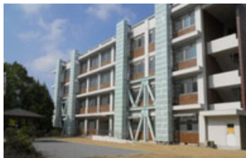
老朽改善された施設
