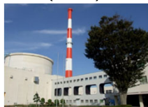
高速実験炉「常陽」
