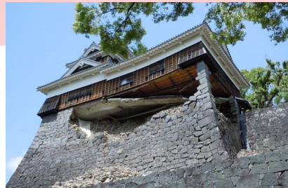
大型地震により石垣が崩壊 【特別史跡 熊本城跡（熊本県熊本市）】
