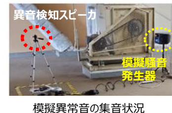
模擬異常音の集音状況
