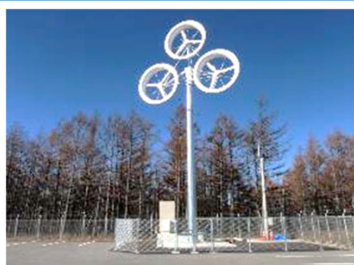
小型風力発電設備
