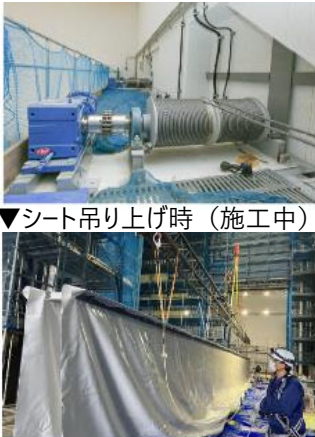
▼駆動モータ設置時（施工中）
