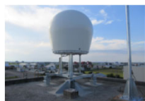
図3 福井空港新設レーダ (X帯二重偏波)
