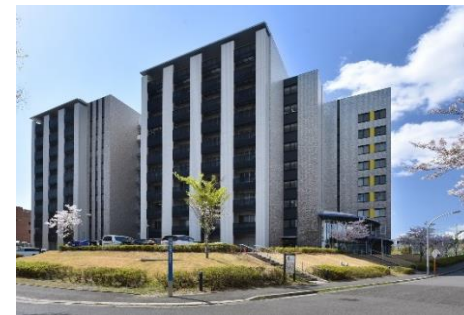
大阪大学テクノアライアンス棟
