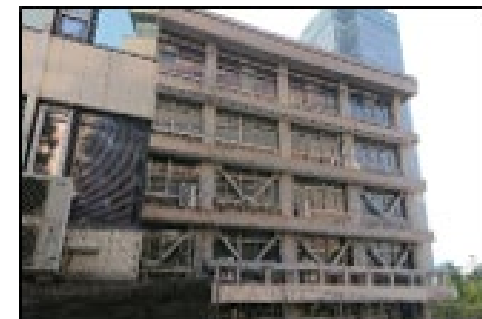
【市谷事務所の外観(改修前)】
