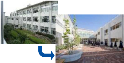
長寿命化改修による教育環境向上と老朽化対策の一体的整備
