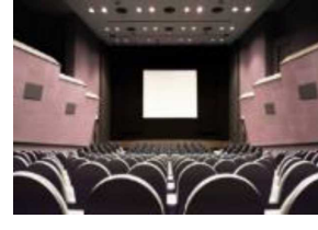
来館者の安心安全に資するため上映ホールの特設天井等にかかる脱落防止対策を実施
