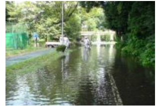
▲排水不良による構内冠水
