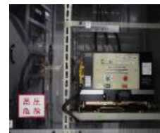
受配電設備の更新
