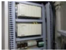
空調自動制御システムの更新
