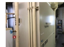
空調機更新（放送研究棟）
