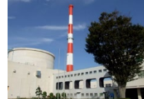
高速実験炉「常陽」
