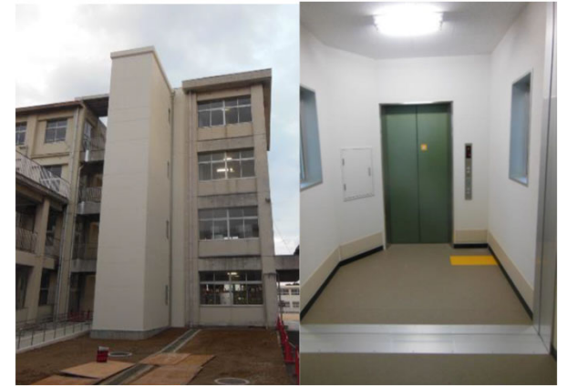
兵庫県明石市立 二見北小学校(平成25年11月)
