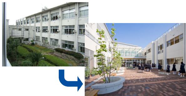
長寿命化改修による教育環境向上と老朽化対策の一体的整備
