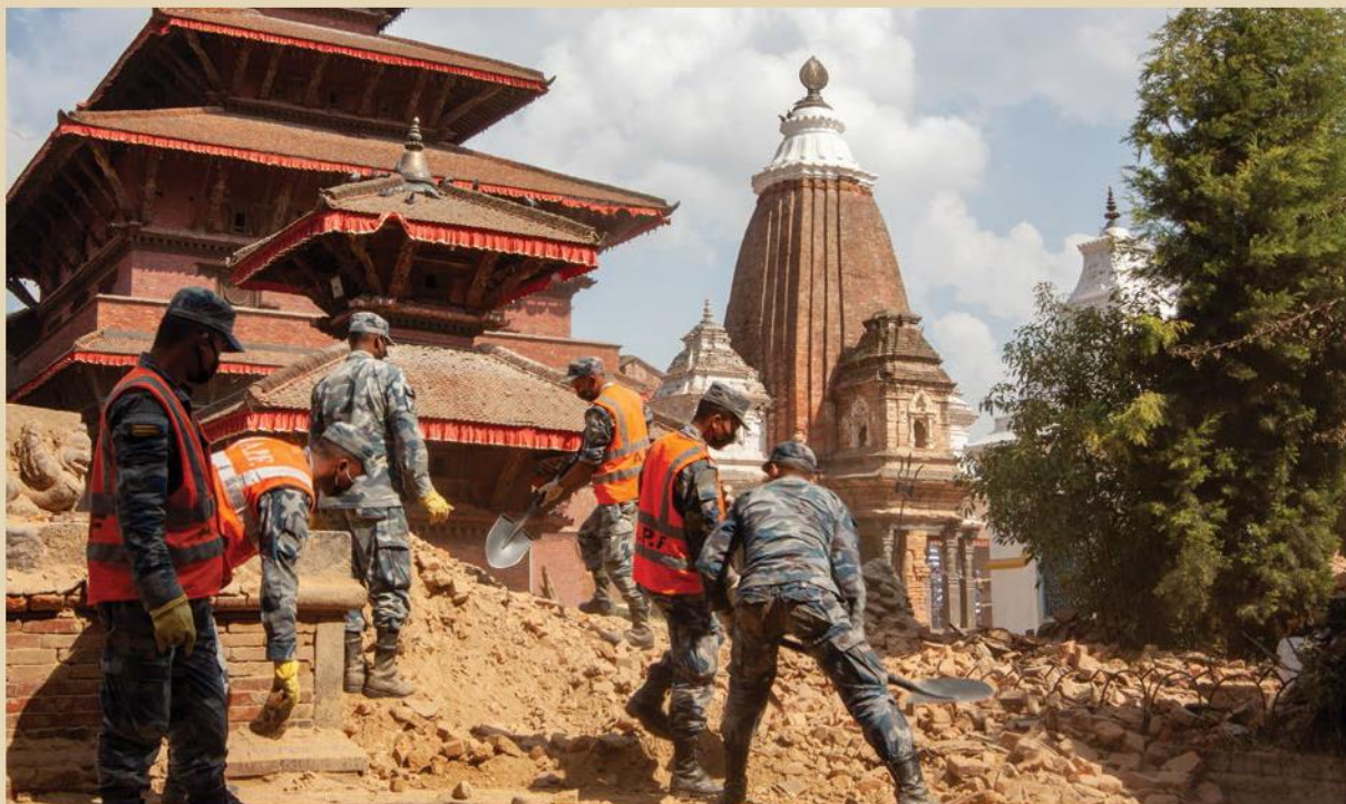
がれきの撤去作業を行うネパールの武装警察部隊（ネパール、カトマンズ）
