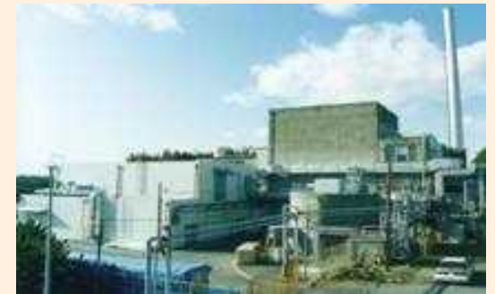
解体中の原子力施設
