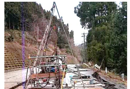
ボーリング調査(国道249号) 輪島市(国土交通省資料より)
