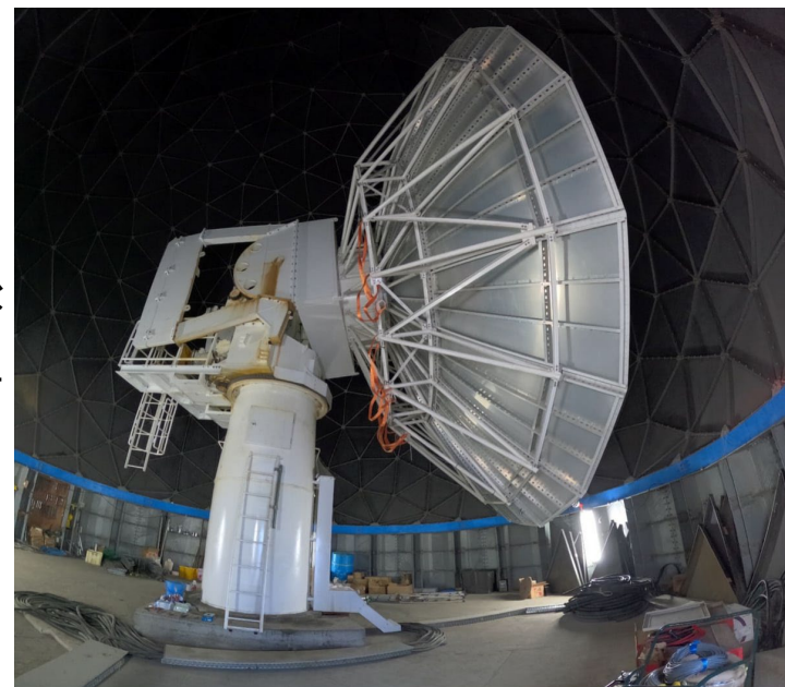
VLBI観測に用いるレドーム内多目的アンテナ
