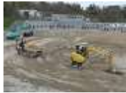
鹿島建設(株) 自動化施工技術
