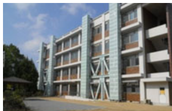
老朽改善された施設
