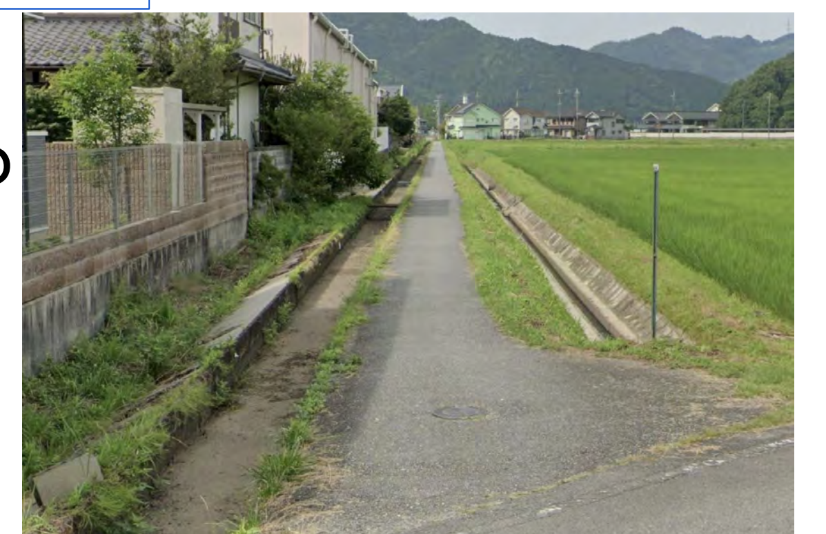
篠山市東吹、餃子の王将の近く：側溝の幅が広いが蓋がされていないため自転車ごとはまる
