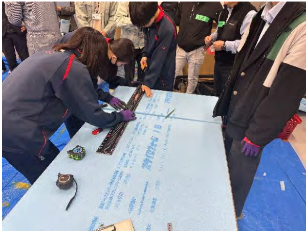
図3：断熱材のカット（スタイロフォーム）と廊下側の壁へのベニヤ板の打ち付け
