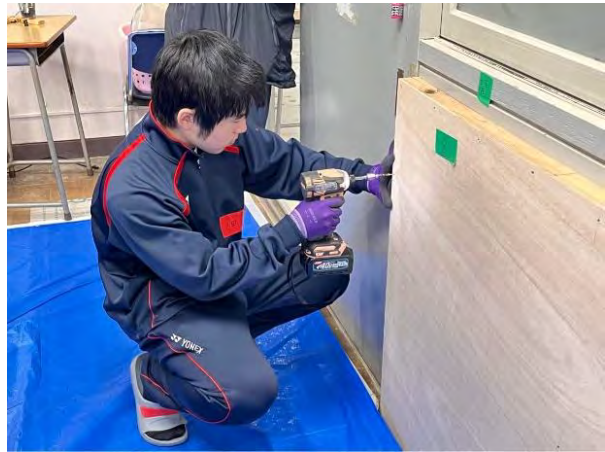
図3：断熱材のカット（スタイロフォーム）と廊下側の壁へのベニヤ板の打ち付け
