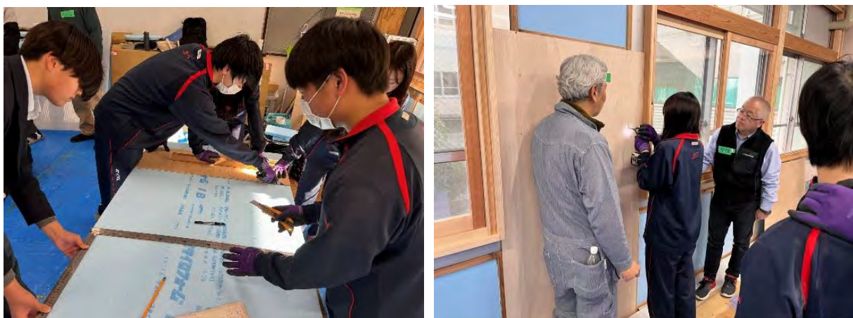
図2：断熱材のカット(スタイロフォーム)と中庭側の壁へのベニヤ板の打ち付け
