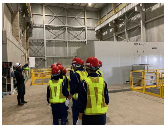
〈釧路火力発電所〉
