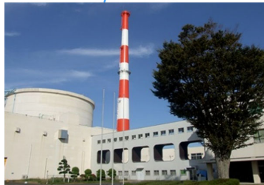
高速実験炉「常陽」
