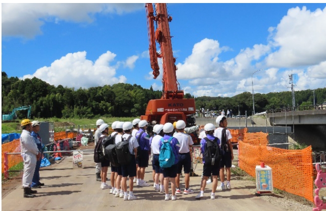
[一宮川河川工事現場の見学]
