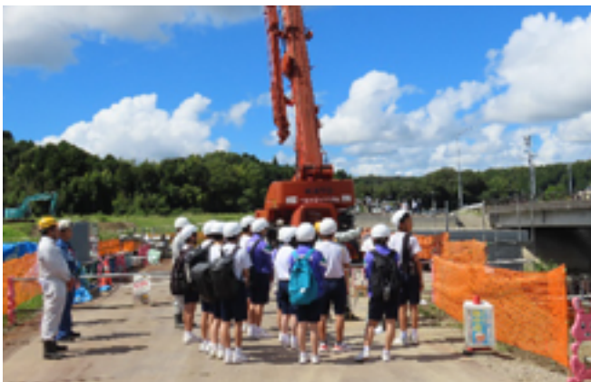
[一宮川河川工事現場の見学]
