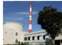
高速実験炉「常陽」
