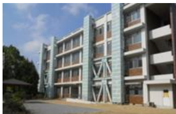
老朽改善された施設
