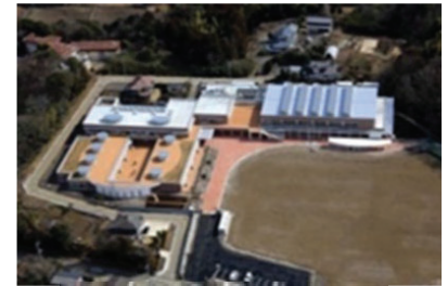
小学校の改修事業
