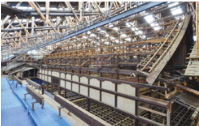
大徳寺方丈及び玄関 屋根解体中 (写真提供：京都府)
