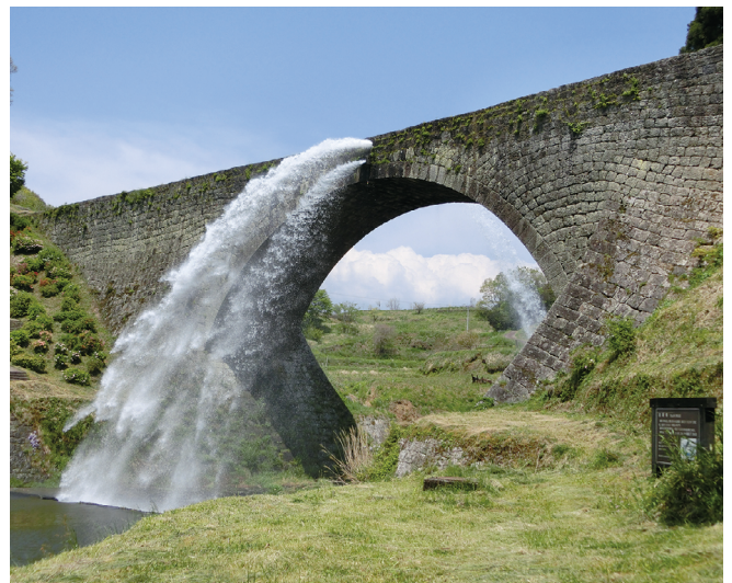
国宝(建造物)「通潤橋」(写真提供：山都町教育委員会)(令和5年9月指定)
