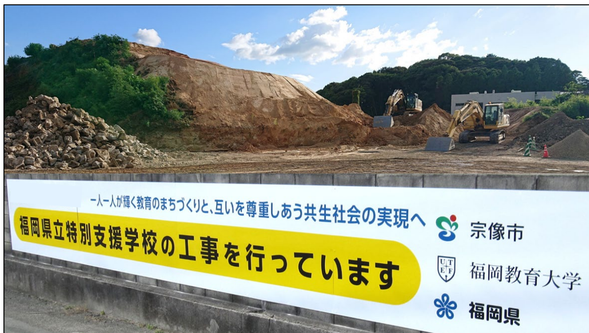
写真：宗像市による造成工事の様子（福岡教育大学（無償貸与）用地）
