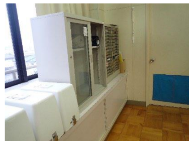
写真2 積み重ねられ 固定されていない棚
