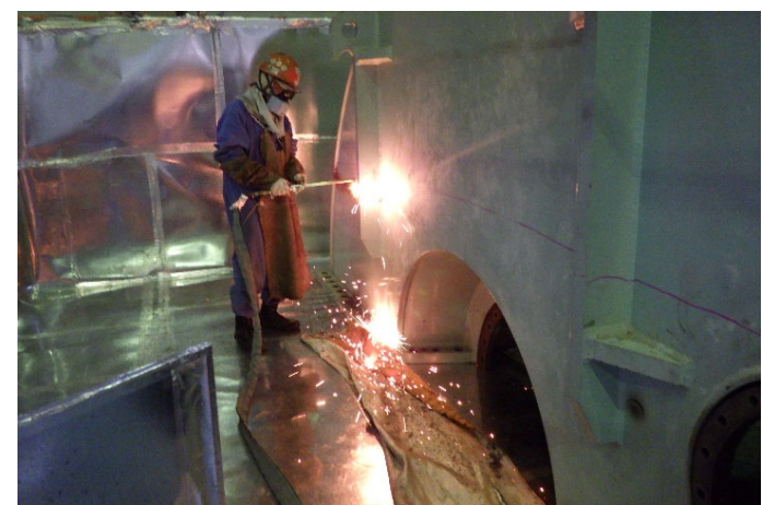
低圧タービン外部車室のガス溶断作業
