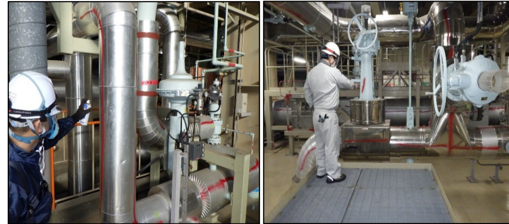
今回解体対象設備となる配管等に赤色のマーキングを施した。
