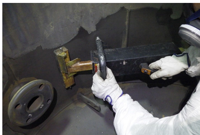
ライニング剥離作業 (IH式被膜除去装置)
