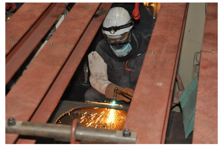
給水加熱器胴部のガス溶断作業
