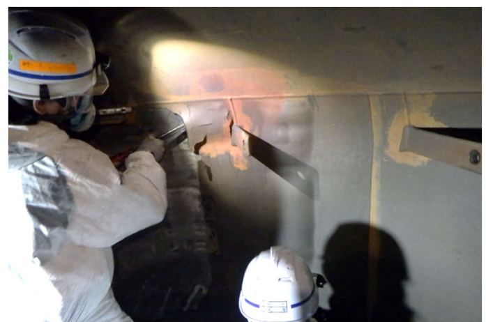
ライニング剥離作業 (スクレイパー)
