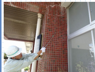
12条点検実施状況 タイルの打音検査
