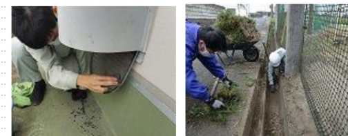
(職員DIY) 防虫網の目詰まりの除去、敷地内排水路の清掃
