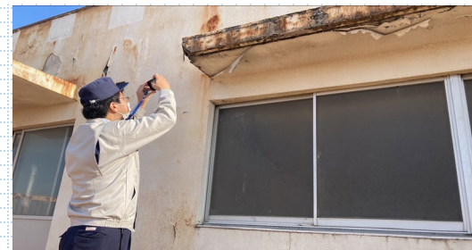
巡回点検にて庇の劣化状況を確認している様子
