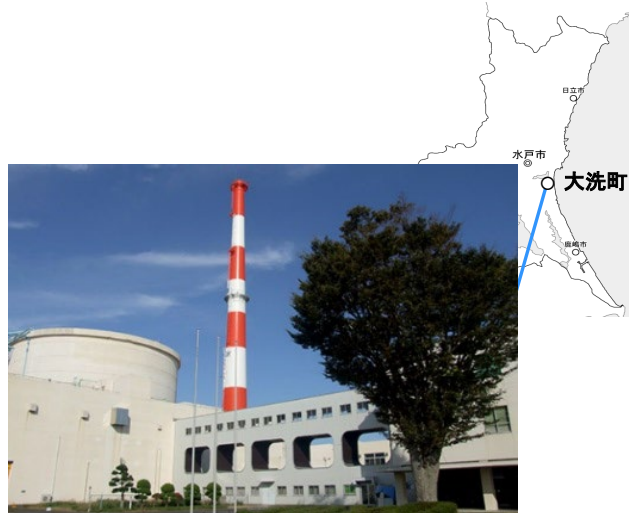
高速実験炉「常陽」
