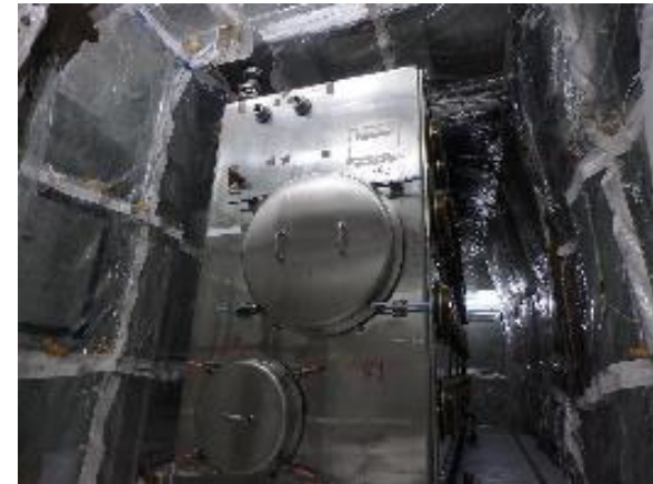
飛散防止(グリーンハウス)の設営
