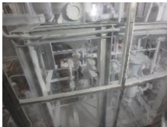
グローブボックス内の機器の解体
