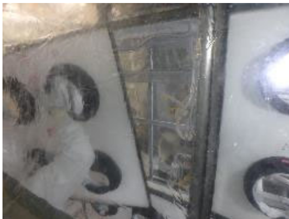
グローブボックスの解体(パネル)
