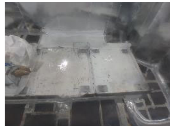
グローブボックス下部の解体
