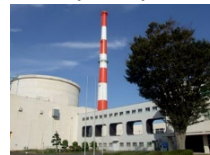
高速実験炉「常陽」
