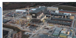
ITERサイトの建設状況(2023.4)
