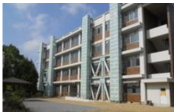
老朽改善された施設
