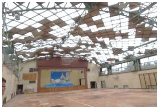
台風で屋根が消失した体育館
