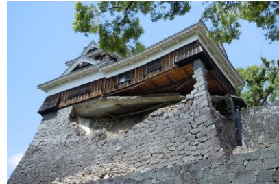
大型地震により石垣が崩壊 【特別史跡 熊本城跡 (熊本県熊本市)】
