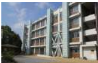
老朽改善された施設
