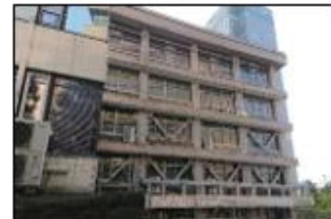
【市ヶ谷事務所の外観(改修前)】
