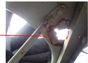
電動ファンの架台の腐食（孔空き）
