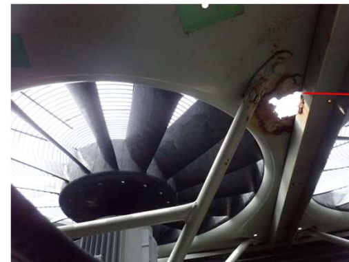
電動ファンの架台の腐食（孔空き）
