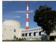
高速実験炉「常陽」
