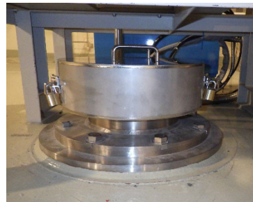
地下台車の新燃料移送機側案内管の閉鎖
