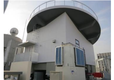
図9 振動実験、地震再現シミュレーション実験室(屋上)
