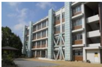
老朽改善された施設
