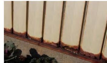
広範囲に、さび・腐食・ぐらつき・取付金物の腐食があり、内部の床に水たまり、漏水が複数箇所ある。
