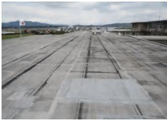
広範囲に、ひび割れ、変質(摩耗)、排水不良、土砂の堆積、雑草が見られ、最上階天井に漏水痕がある。
