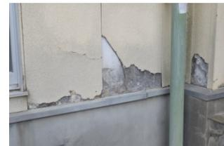
欠落・ぐらつき・取付金物の腐食・シーリング材の欠落があり、内部の床に水たまり、漏水が複数箇所ある。
