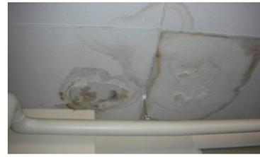
広範囲に、損壊、幅広のひび割れ、排水不良があり、最上階天井に漏水が複数箇所ある。
