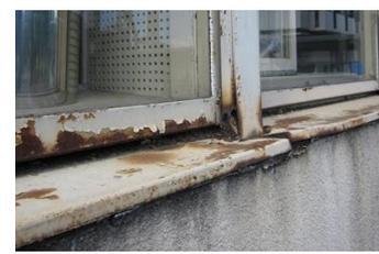
全体的に腐食・損壊・開閉不良があり、漏水がある。
