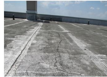
広範囲に、破断、損壊、下地露出、幅広のひび割れがあり、最上階天井に漏水が複数箇所ある。
