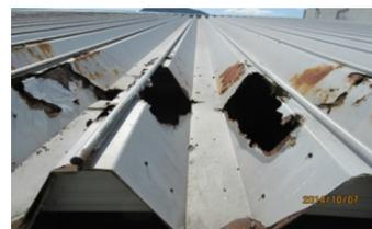
広範囲に、さび、はがれ、腐食、取付金物の損壊があり、最上階天井に漏水が複数箇所ある。
