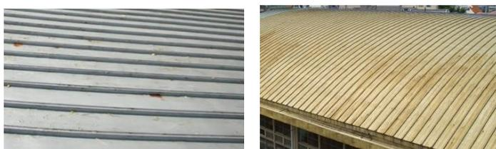
広範囲に、塗装のはがれ、さび、変質、シーリング材のひび、取付金物のさび、部分的な腐食・損壊があり、最上階天井に漏水痕がある。
