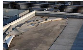
広範囲に、破断、めくれ、下地露出があり、最上階天井に漏水が複数箇所ある
