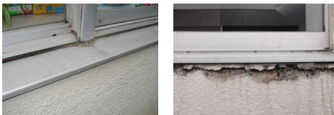
全体的に、変形・変質・さび・シーリングの硬化・ひび割れが見られる。
