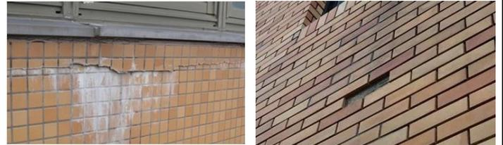
広範囲に、剥落・爆裂・幅広のひび割れがあり、内部の床に水たまり、漏水が複数箇所ある。
