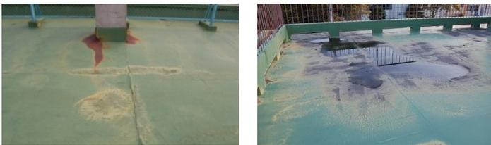
広範囲に、ふくれ、しわ、穴あき、変質(摩耗)、排水不良、土砂の堆積、雑草が見られ、最上階天井に漏水痕がある。
