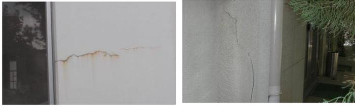
広範囲に、ひび割れ・亀甲状のひび割れ・変質・浮き・剥がれ・さび汁があり、小規模な漏水がある。
