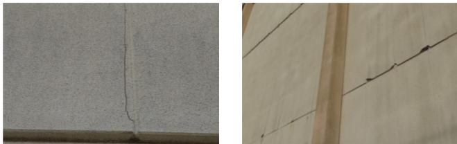
広範囲に、ひび割れ・変質・シーリング材のひび・取付金物のさびがあり、小規模な漏水がある。
