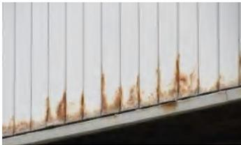
広範囲に、さび・変質・シーリング材のひび・取付金物のさびがあり、小規模な漏水がある。
