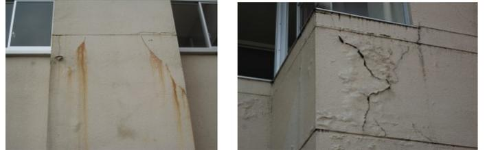
広範囲に、剥落・爆裂・幅広のひび割れがあり、内部の床に水たまり、漏水が複数箇所ある。
