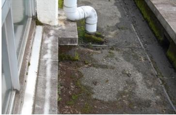
広範囲に、ひび割れ、変質、排水不良、土砂の堆積、雑草、目地シーリングの損傷が見られ、最上階天井に漏水痕がある。
