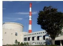
高速実験炉「常陽」
