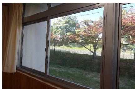
複層ガラスによる断熱化
