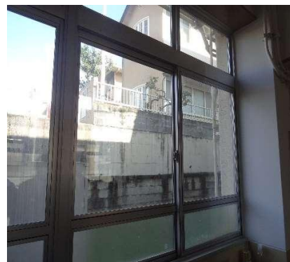
複層ガラスによる断熱化
