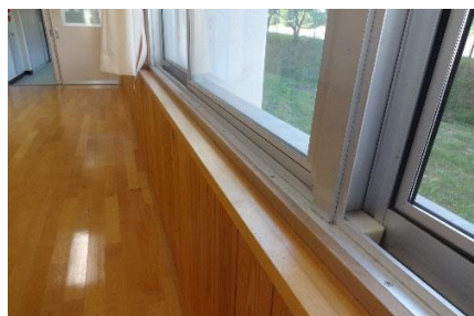
外壁の断熱化 (内断熱)
