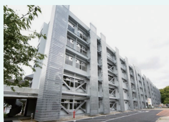
耐震補強と外壁の改修
