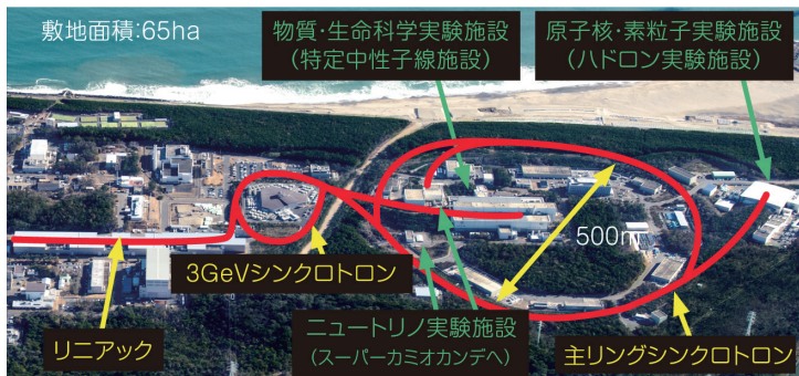
大強度陽子加速器施設 (J-PARC) (写真提供: J-PARCセンター)
